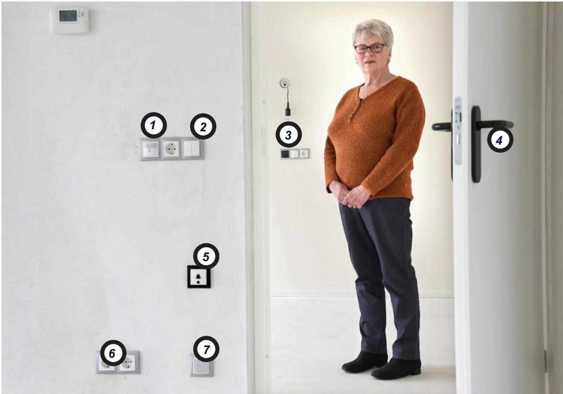
1. bewegingsmelder ; 2. schakelaar voor nacht compensatie verlichting ; 3. zwart vierkant knopje om nachtverlichting in te schakelen ; 4. U-vorm deurklink zodat er minder makkelijk met kleding achter kan haken ; 5. alarmknop (laag indien gevallen) ; 6. contrastkader om stopcontacten ; 7. routelamp
